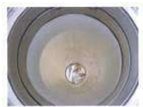
写真 4-4 試験後の内面状況
