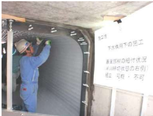
写真 13-5-16 表面部材組付け状況
