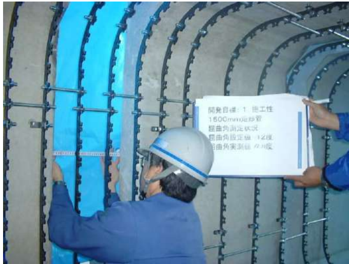
写真 13-2-17 1,500 mm 矩形管 屈曲角測定状況
