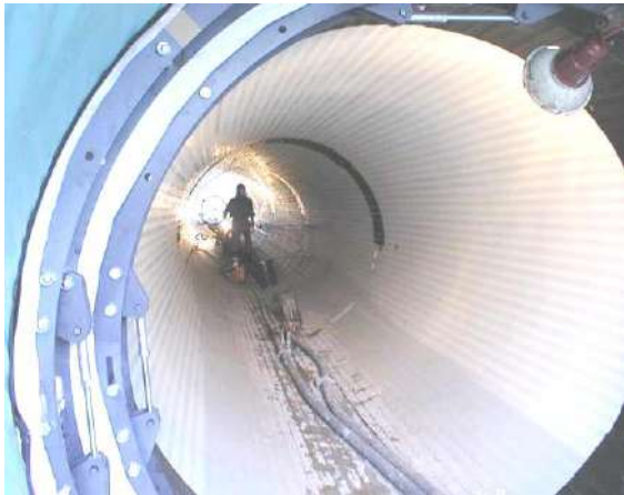
写真 13-1-5 充填材充填用の型枠
