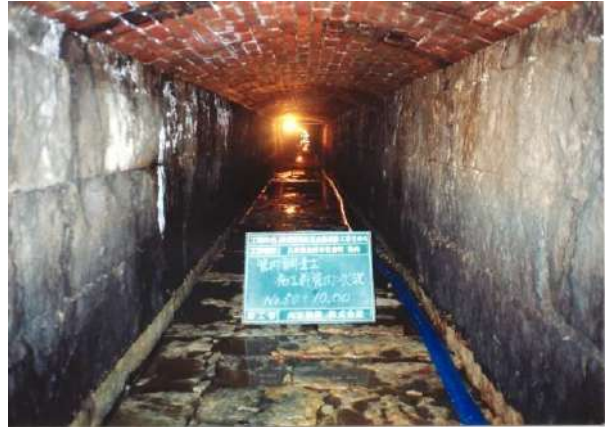
写真 19-2-1 既設管内の状況
