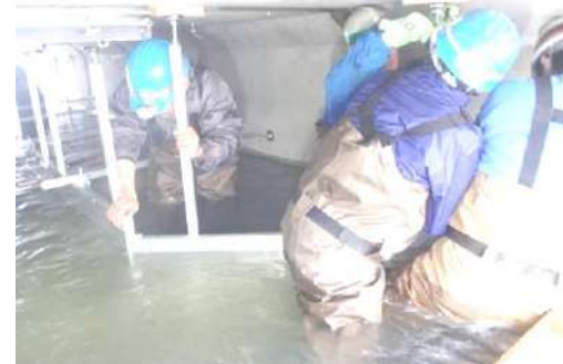
写真 13-5-13 上流側仕切板設置状況
