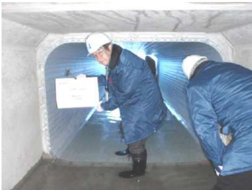
写真 13-5-28 下流側管口状況
