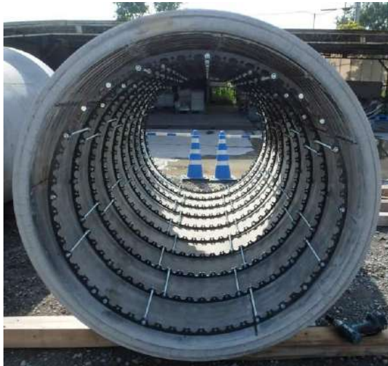
写真 9-2-3 呼び径 1,200 更生管
