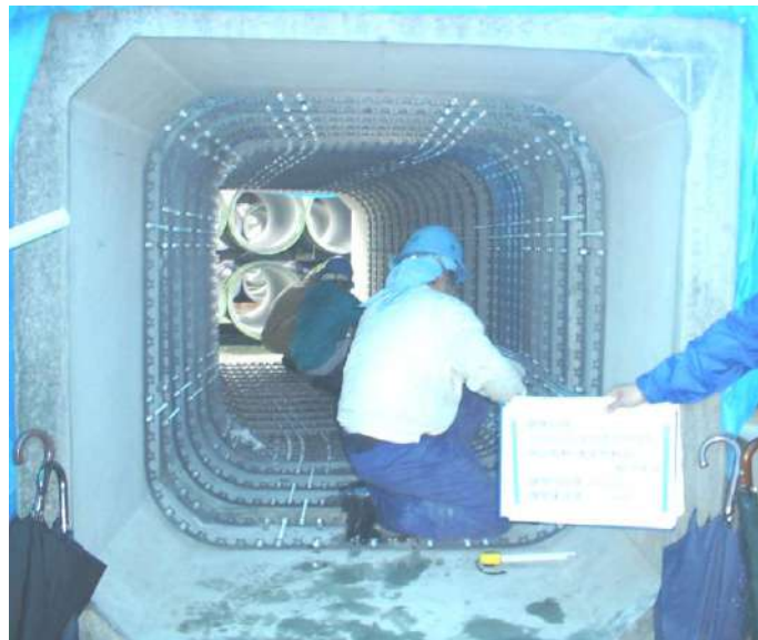
写真 13-2-18 1,500 mm 矩形管 かん合部材組立て状況
