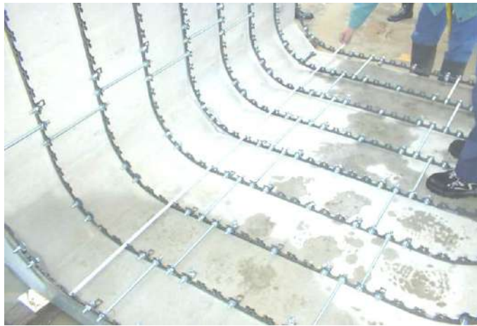
写真 13-4-4 矩形管の長さ測定状況
