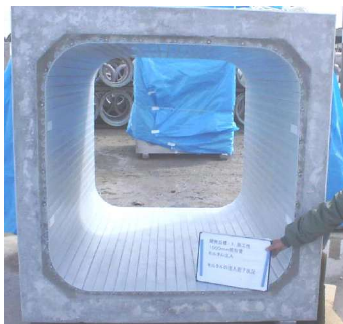
写真 13-3-6 1,500 mm 矩形管 更生完了
