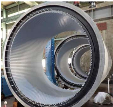
写真 9-1-3 呼び径 3,000 更生管
