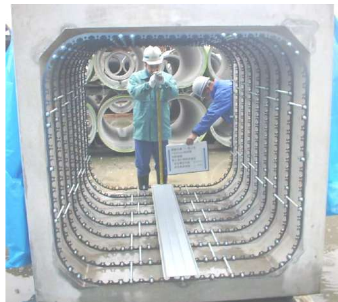
写真 13-4-6 更生管の高低差確認 (実測値 23 mm)
