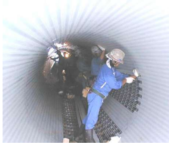
写真 13-1-4 表面部材のかん合状況
