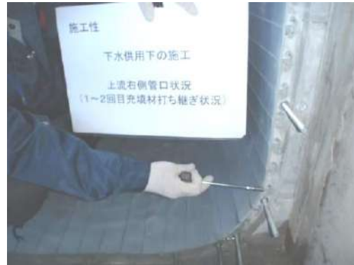
写真 13-5-27 充填材打ち継ぎ状況
