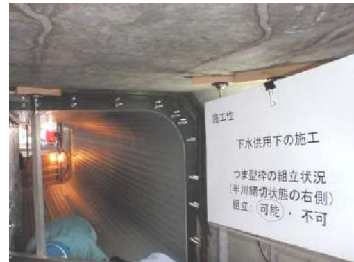
写真 13-5-17 つま型枠組立て状況
