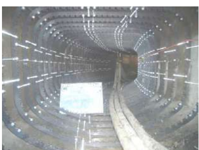
写真 13-5-7 管内水替え状況 写真 13-5-8 鋼製リング組立て状況 写真 13-5-9 表面部材組付け状況
