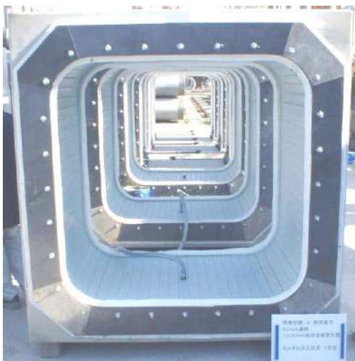
写真 9-3-12 40 mm 減肉全面更生管の充填材注入状況
