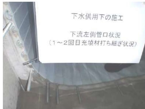
写真 13-5-29 充填材打ち継ぎ状況
