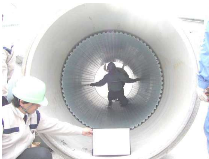
写真 13-3-3 1,500 mm 円形管 更生完了
