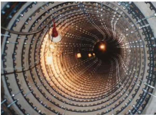
写真 19-1-1 鋼製リングの組立て状況
