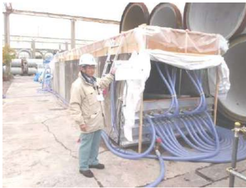
写真 13-5-10 模擬配管(上流側)
