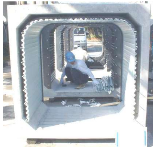
写真 9-3-8 40 mm 減肉門形更生管の表面部材組付け状況
