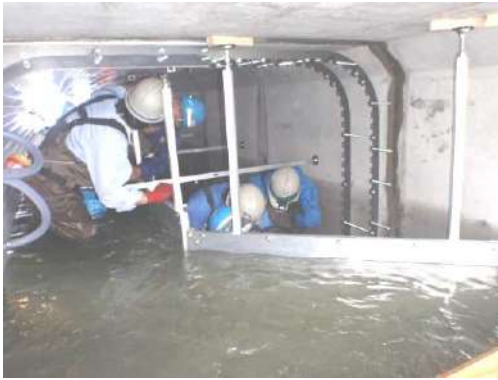
写真 13-5-14 鋼製リング組立て状況
