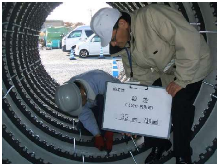
写真 13-2-6 呼び径 1,650 円形管段差部 段差量測定状況
