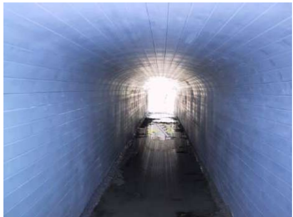
写真 19-2-5 更生後管内状況
