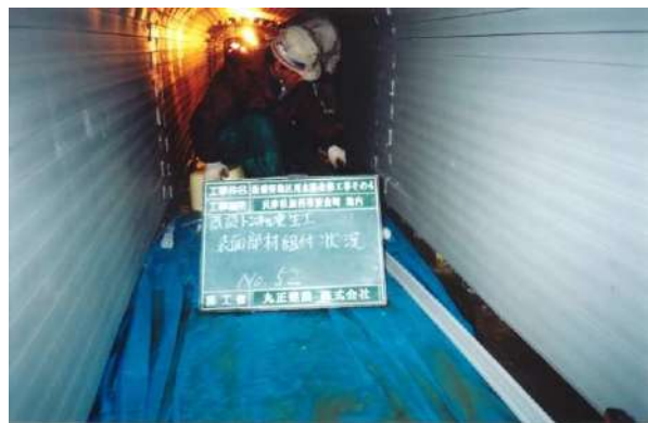
写真 19-2-3 表面部材の組立て状況
