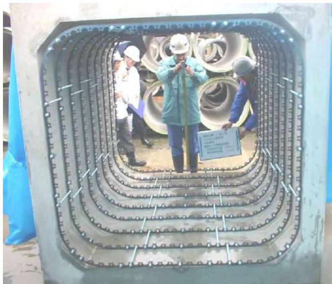
写真 13-4-5 鋼製リング高低差確認 (実測値 23 mm)
