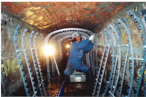
写真 19-2-2 鋼製リングの組立て状況
