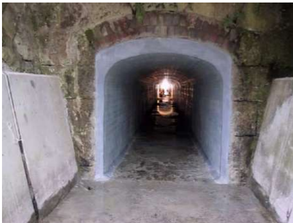
写真 19-2-4 更生後管口状況
