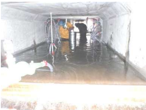
写真 13-5-24 充填材 4 回目注入状況
