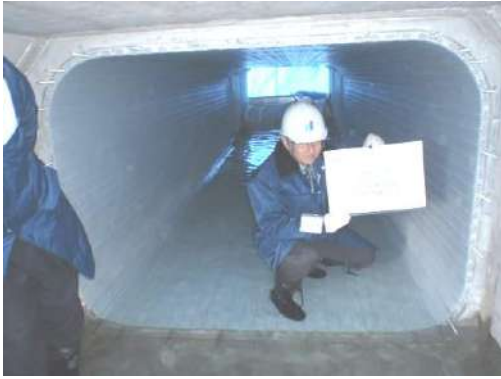
写真 13-5-26 上流側管口状況
