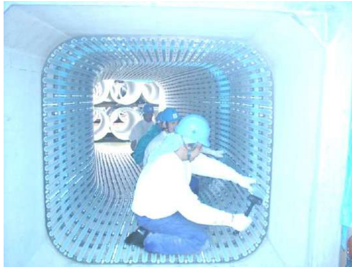
写真 13-2-20 1,500 mm 矩形管 表面部材組立て状況
