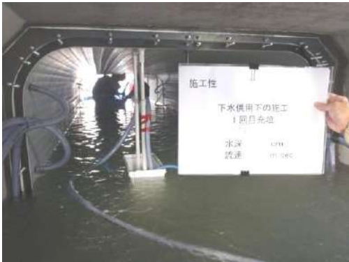
写真 13-5-22 充填材 1 回目注入状況
