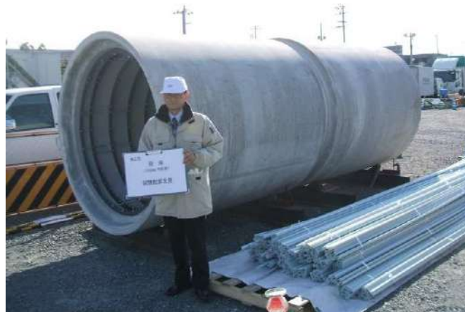
写真 13-2-2 円形管段差部の施工性試験配管
