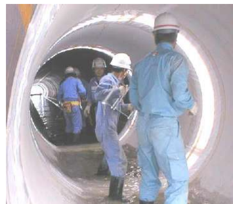
写真 13-1-2 鋼製リング搬入作業
