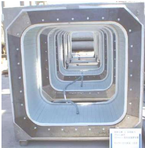
写真 9-3-10 25 mm 減肉全面更生管の充填材注入状況
