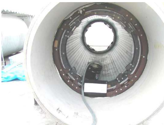
写真 13-3-2 1,500 mm 円形管 充填材注入状況
