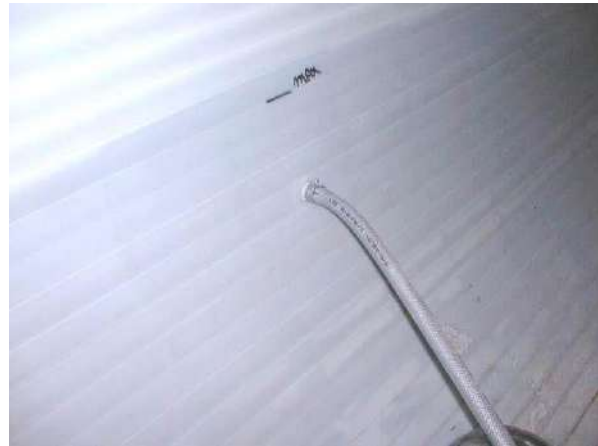
写真 13-1-6 充填材充填の状況
