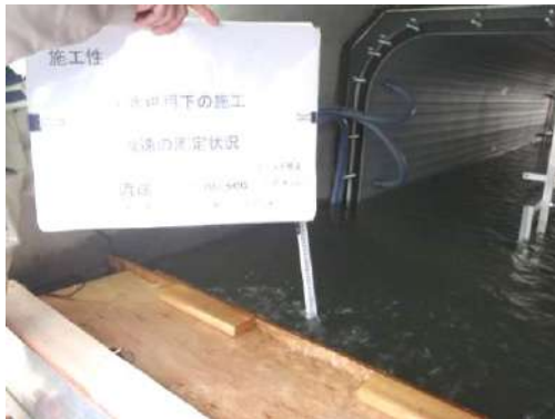
写真 13-5-12 水深・流速測定状況
