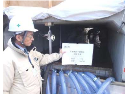
写真 13-5-21 充填材 1 回目注入状況
