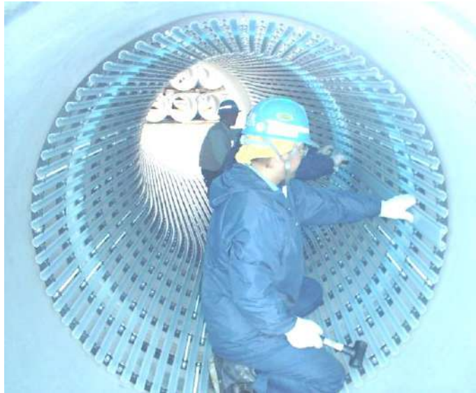
写真 13-2-9 呼び径 1,500 円形管 表面部材組立て状況
