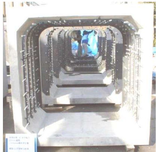
写真 9-3-2 25 mm 減肉門形更生管の鋼製リング組立て状況
