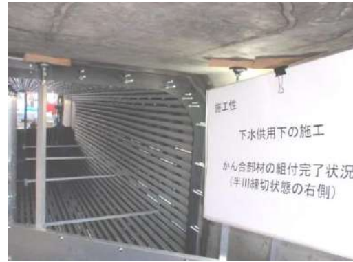
写真 13-5-15 かん合部材組付け完了状況
