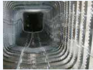
段差部の鋼製リング施工状況
