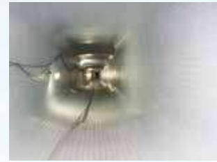
段差部の更生内面
