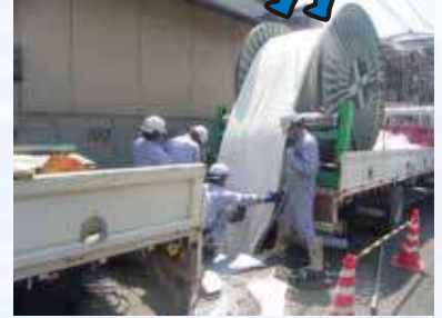
SZライナーをマンホールより 管きょ内に引き込み中
