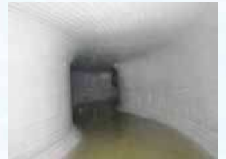
S字屈曲部の更生内面
