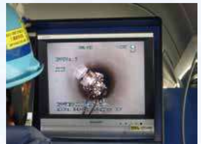
管きょ内から取付管口を穿孔中
