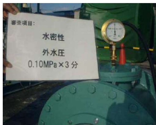
写真 28 外水圧試験状況
