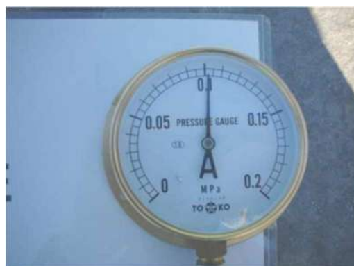
写真 26 内水圧試験状況
