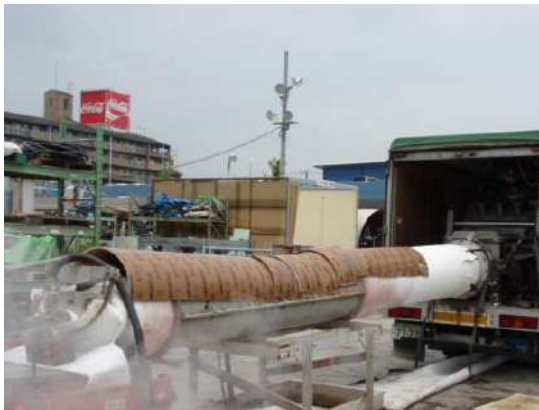
写真 1 8 φ 600のライニング状況
