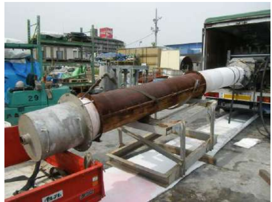
写真 1 9 φ 450のライニング状況
