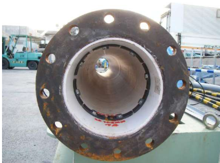
写真13 最大軸方向変位量と最大屈曲角での管内状態
