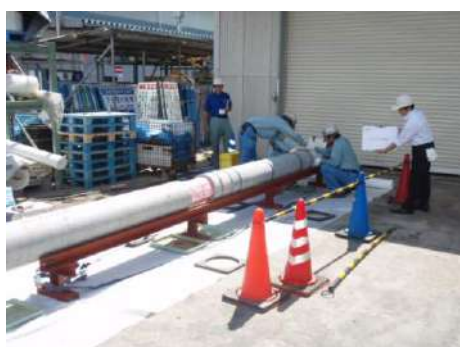
写真 4 ライニング状況
