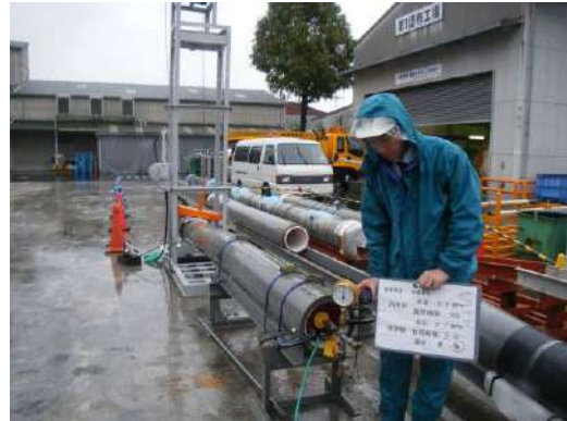
写真 1 1 水圧試験状況
