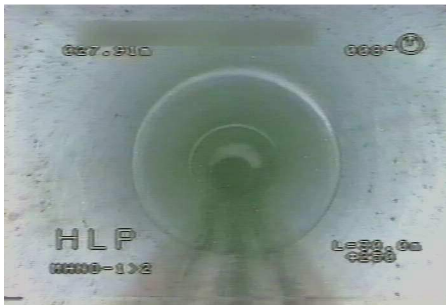
写真 2 2 ホースライニング工法施工管
