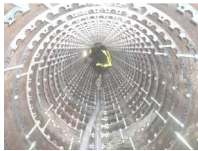
写真 13-5-2 鋼製リング組立て状況
