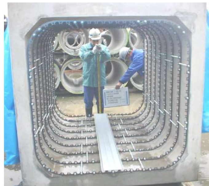
写真 13-4-6 更生管の高低差確認 (実測値 23 mm)
