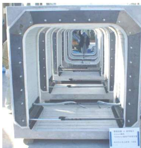
写真 9-3-13 40 mm 減肉門形更生管の充填材注入状況
