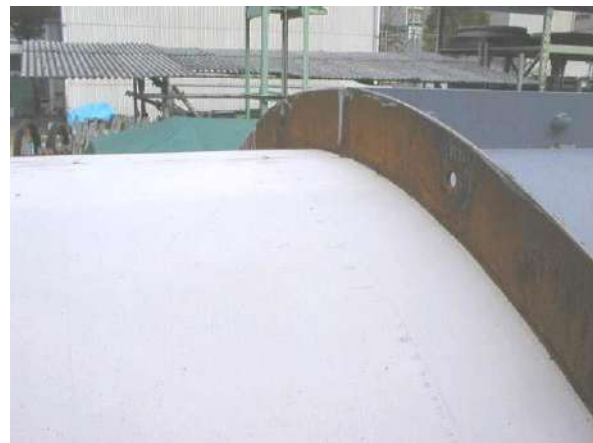
写真 13-1-8 天頂部充填材充填の完了状況
