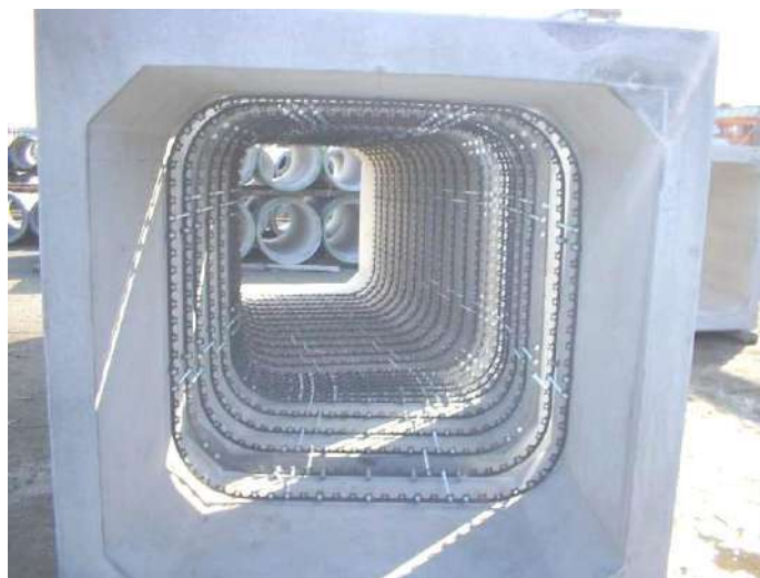
写真 13-2-15 1,500 mm 矩形管 鋼製リング組立て完了状況
