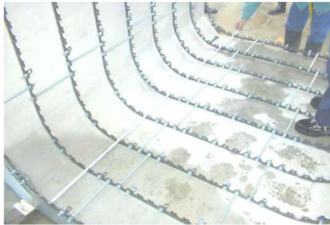
写真 13-4-4 矩形管の長さ測定状況
