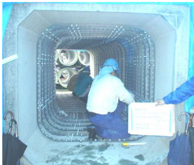
写真 13-2-18 1,500 mm 矩形管 かん合部材組立て状況
