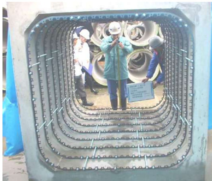
写真 13-4-5 鋼製リング高低差確認 (実測値 23 mm)
