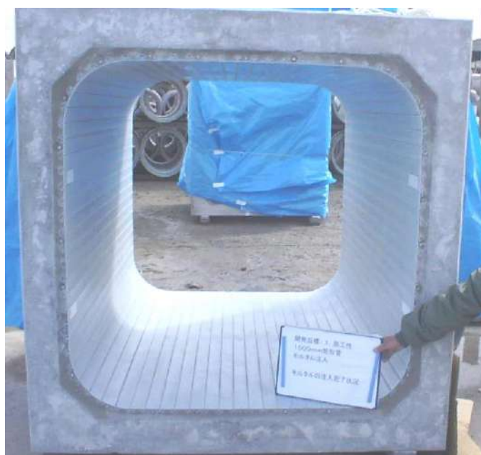
写真 13-3-6 1,500 mm 矩形管 更生完了
