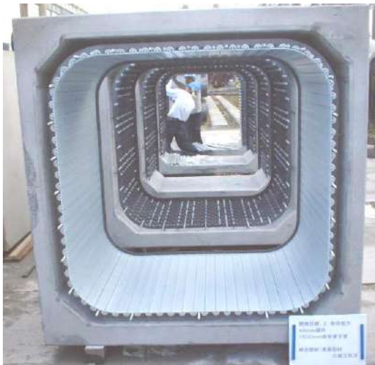
写真 9-3-7 40 mm 減肉全面更生管の表面部材組付け状況
