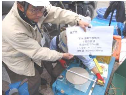
写真 13-5-19 フロー値測定状況
