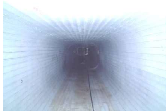
写真 19-1-2 直線部の施工状況
