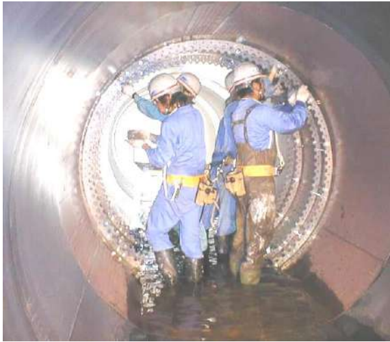
写真 13-1-3 鋼製リングの組立て作業
