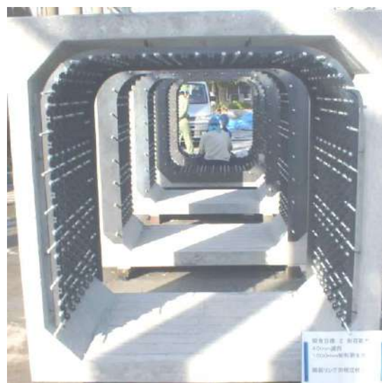
写真 9-3-4 40 mm 減肉門形更生管の鋼製リング組立て状況
