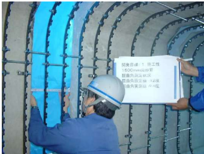
写真 13-2-17 1,500 mm 矩形管 屈曲角測定状況
