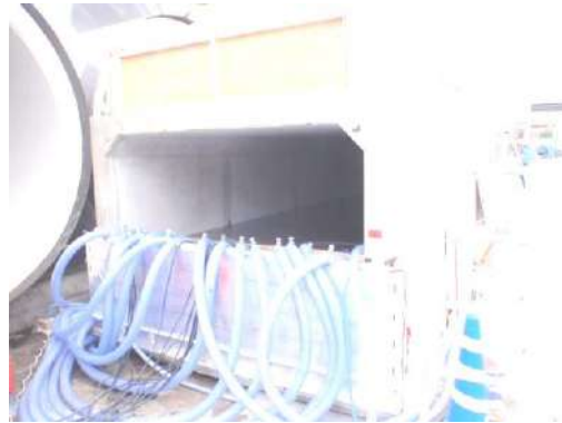
写真 13-5-11 模擬配管(下流側)
