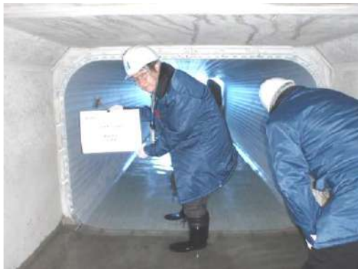
写真 13-5-28 下流側管口状況
