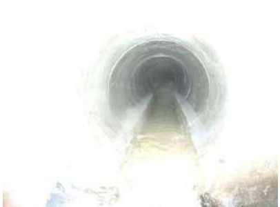
写真 13-5-4 下水供用状況
