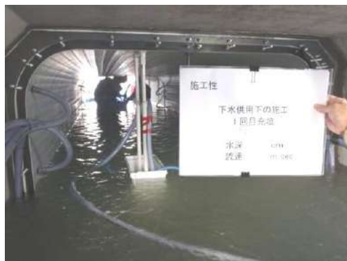
写真 13-5-22 充填材 1 回目注入状況
