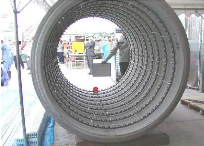
写真 13-4-2 鋼製リング高低差確認（実測値 19 mm）
