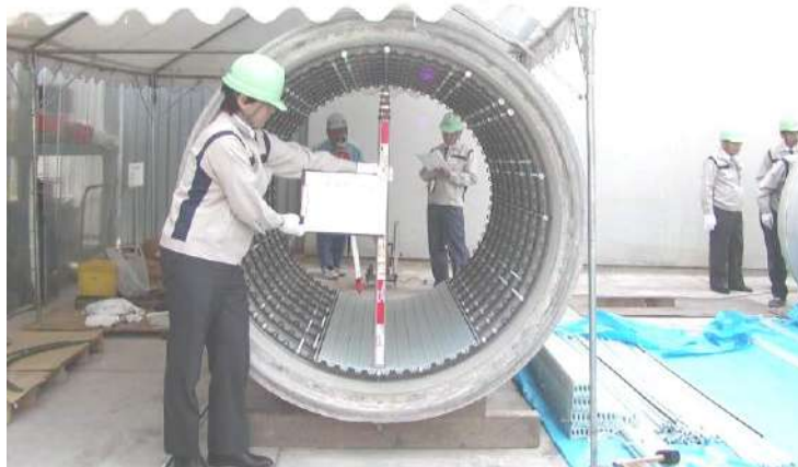
写真 13-4-3 更生管の高低差確認（実測値 19 mm）
