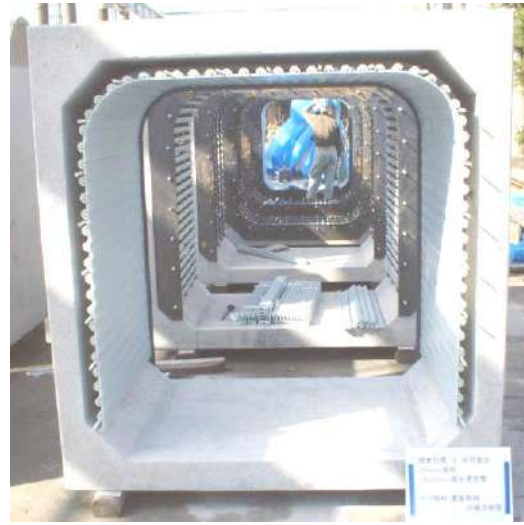
写真 9-3-6 25 mm 減肉門形更生管の表面部材組付け状況
