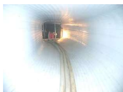
写真 13-5-9 表面部材組付け状況
