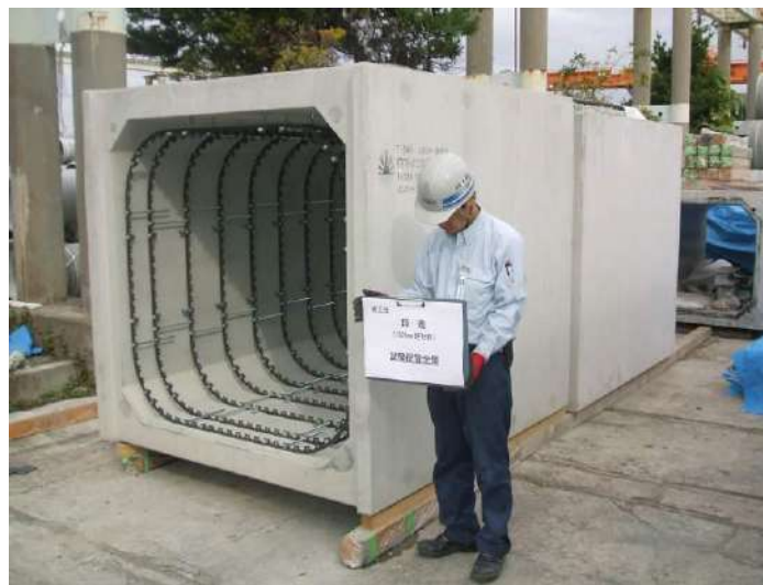
写真 13-2-13 矩形管段差部の施工性試験配管
