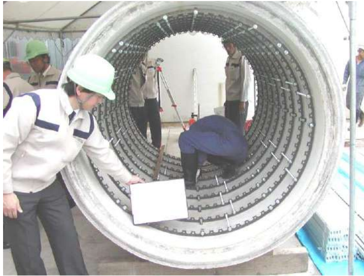
写真 13-4-1 円形管の高さ調整状況（勾配の調整）
