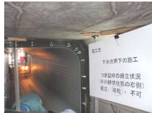
写真 13-5-17 つま型枠組立て状況
