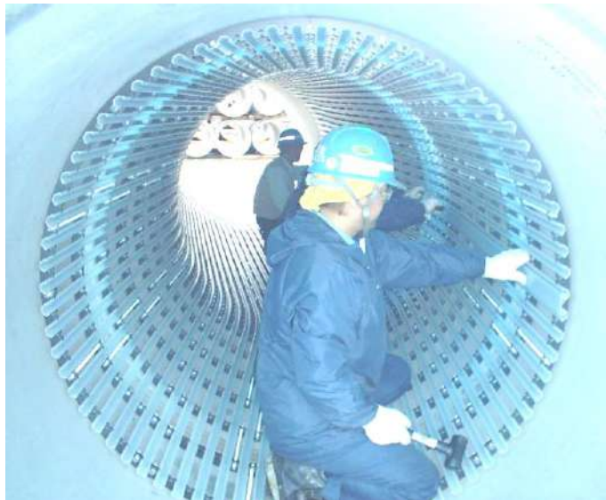
写真 13-2-9 呼び径 1,500 円形管 表面部材組立て状況
