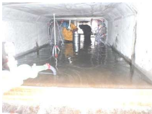
写真 13-5-24 充填材 4 回目注入状況
