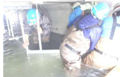
写真 13-5-13 上流側仕切板設置状況
