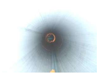
写真 13-5-3 表面部材組付け状況
