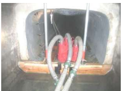
写真 13-5-7 管内水替え状況
