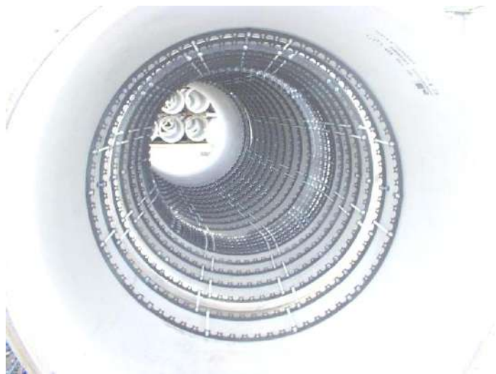
写真 13-2-3 呼び径 1,500 円形管 鋼製リング組立て完了状況
