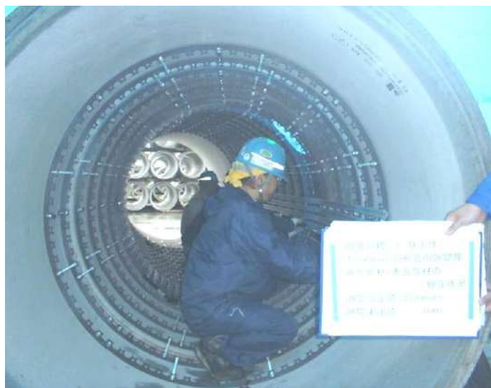
写真 13-2-7 呼び径 1,500 円形管 かん合部材組立て状況
