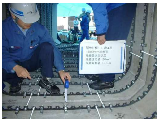
写真 13-2-16 1,500 mm 矩形管 段差量測定状況
