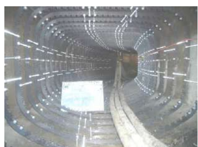
写真 13-5-8 鋼製リング組立て状況
