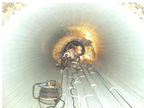
写真 19-2-3 表面部材の組立て状況
