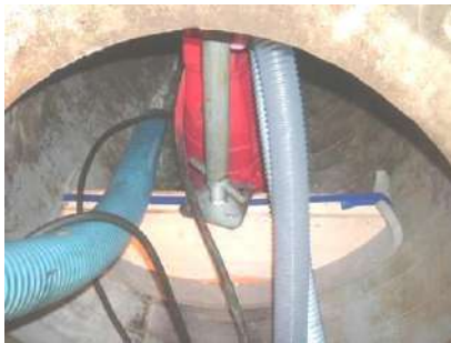
写真 13-5-1 管内水替え状況
