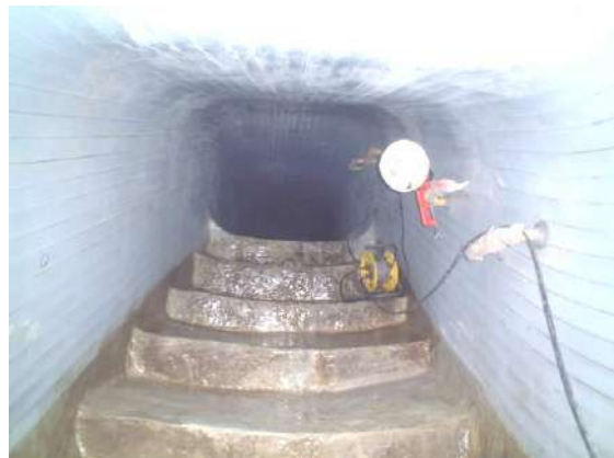
写真 19-1-3 階段部の施工状況
