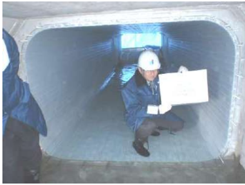
写真 13-5-26 上流側管口状況
