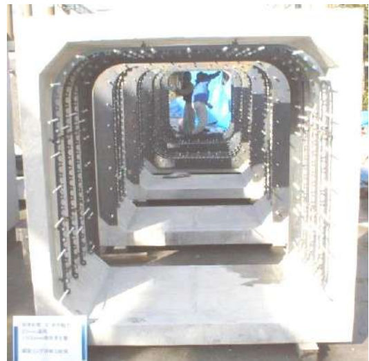
写真 9-3-2 25 mm 減肉門形更生管の鋼製リング組立て状況
