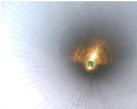
写真 13-1-7 更生管内の仕上げ状況
