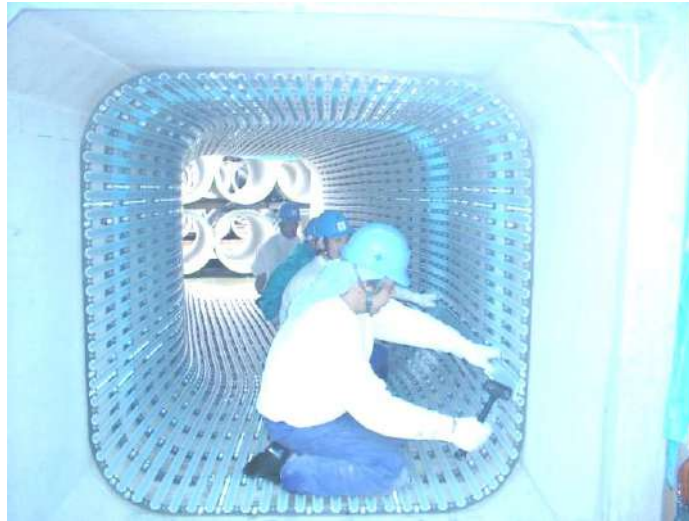
写真 13-2-20 1,500 mm 矩形管 表面部材組立て状況
