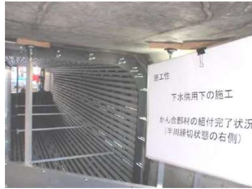
写真 13-5-15 かん合部材組付け完了状況
