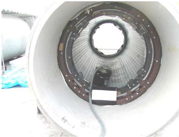
写真 13-3-2 1,500 mm 円形管 充填材注入状況
