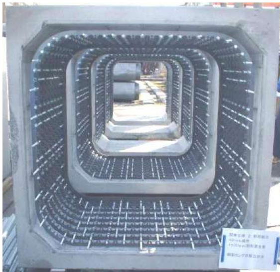
写真 9-3-3 40 mm 減肉全面更生管の鋼製リング組立て状況
