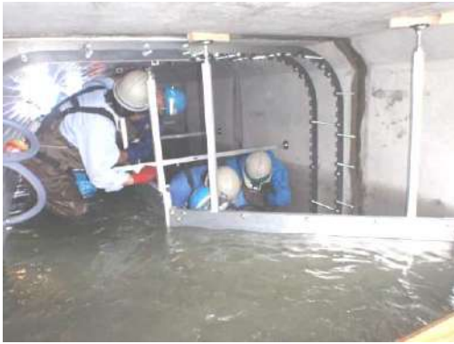
写真 13-5-14 鋼製リング組立て状況
