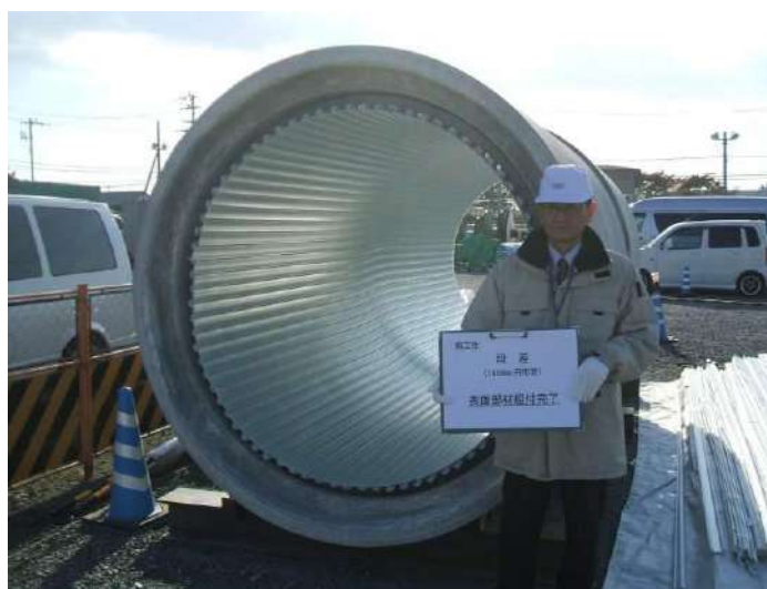
写真 13-2-11 呼び径 1,650 円形管 表面部材組立て完了状況
