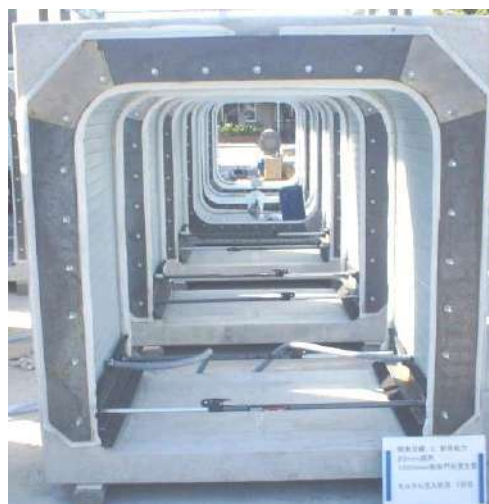
写真 9-3-11 25 mm 減肉門形更生管の充填材注入状況
