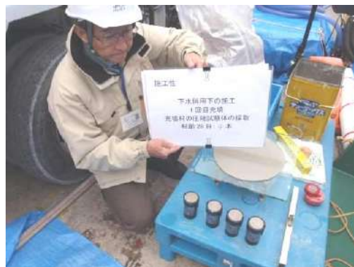
写真 13-5-20 圧縮試験体採取状況
