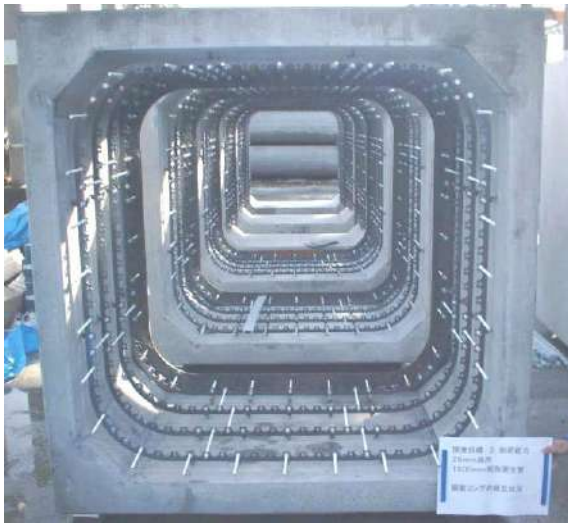
写真 9-3-1 25 mm 減肉全面更生管の鋼製リング組立て状況
