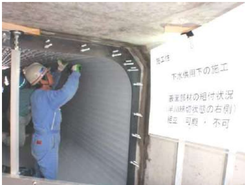
写真 13-5-16 表面部材組付け状況
