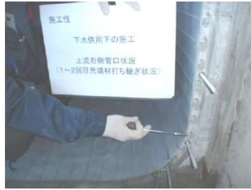
写真 13-5-27 充填材打ち継ぎ状況
