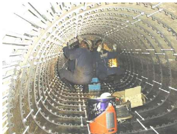
写真 19-2-2 鋼製リングの組立て状況
