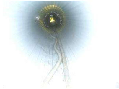
写真 13-5-6 表面部材組付け状況
