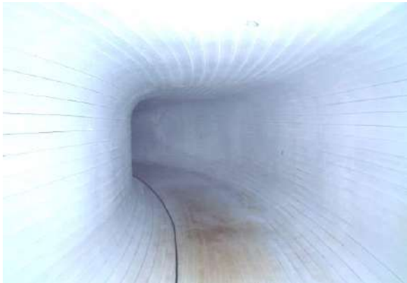
写真 19-1-1 90° 屈曲部の施工状況
