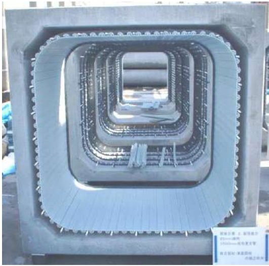
写真 9-3-5 25 mm 減肉全面更生管の表面部材組付け状況
