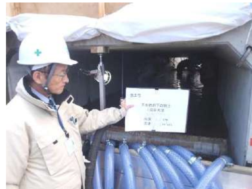
写真 13-5-21 充填材 1 回目注入状況
