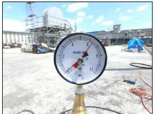
耐圧力試験状況②
