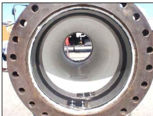
写真 8-10 管端処理の状態
