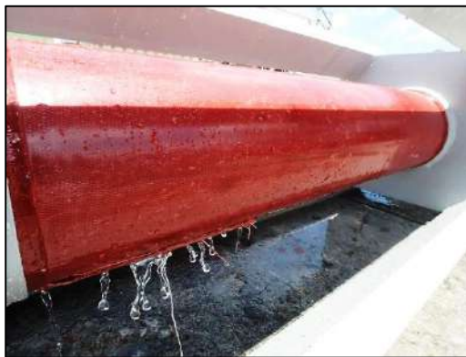
写真 8-5 耐圧力試験状況①
