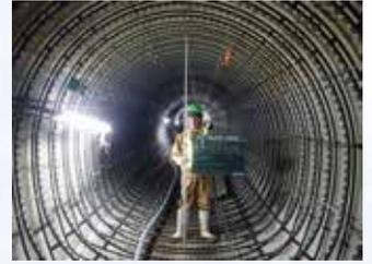
分割された鋼製リングをマンホールから運び入れ、ボルト結合により鋼製リングを組み立てます。
