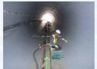
既設管きよと表面部材との間に高流動・高強度な充填材を注入します。
