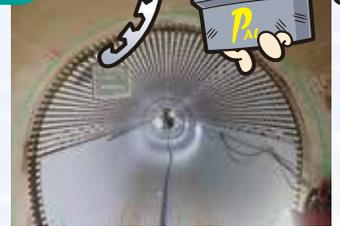
かん合部材、表面部材をマンホールから運び入れ鋼製リングに組み付けます。
